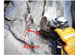
側壁部で鋼アーチのズレを計測 ⇒ 芯-芯で40~50cm
